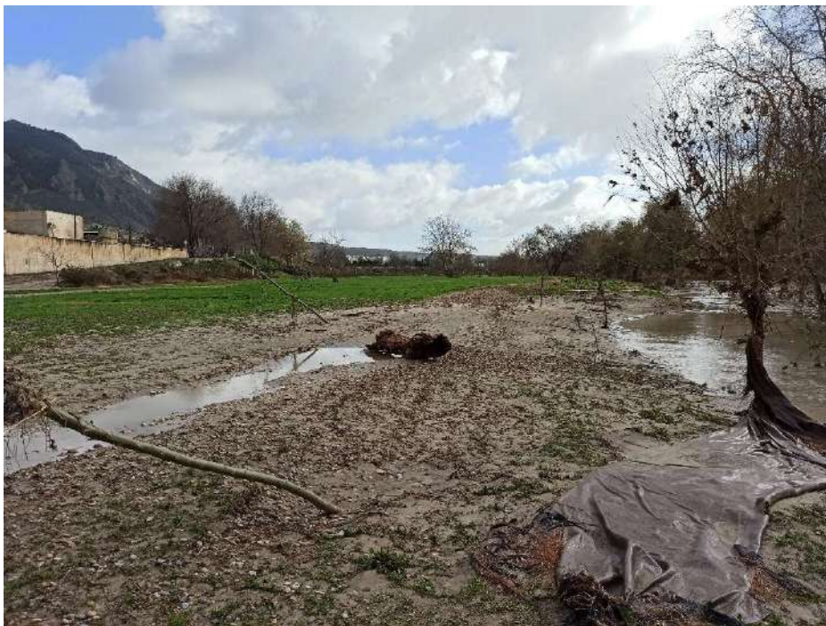
Figura 6. Aspecto de la zona restaurada tras la bajada del nivel del agua. Árboles tumbados por la fuerza de la corriente y geotextiles arrastrados.
