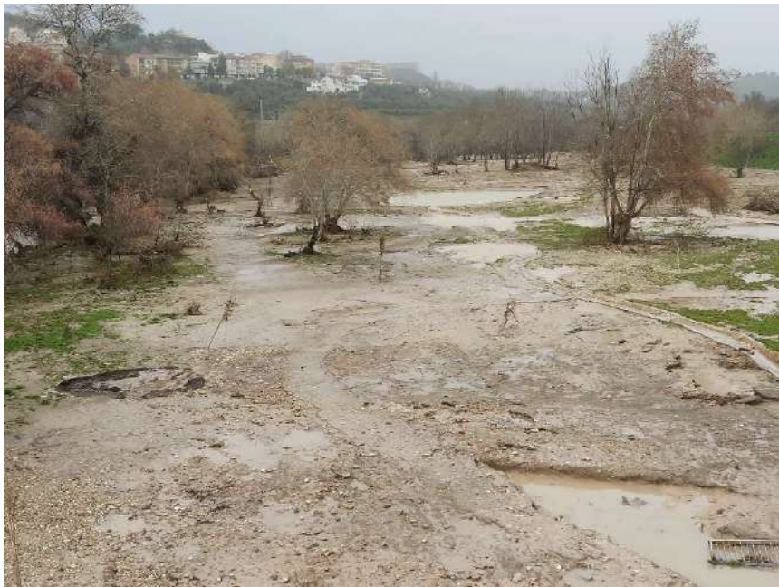
Figura 4. Aspecto de la zona restaurada tras la bajada del nivel del agua. Se puede apreciar la erosión del suelo, la ruptura de las acequias y caminos y los daños sufridos por los arbolitos recién plantados.
