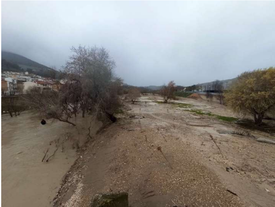
Figura 5. Aspecto de la zona restaurada más cercana al cauce tras la bajada del nivel del agua.
