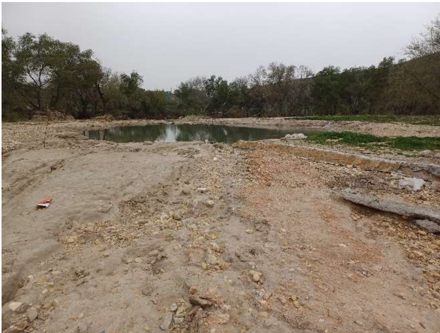
Figura 10. Entorno de una de las lagunas erosionado y con daños en la acequia que la alimenta
